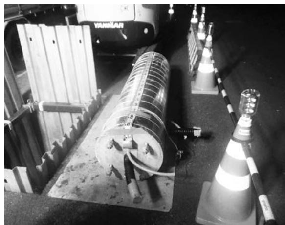
写真-1 照明灯プレキャスト基礎
