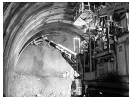
写真-10 コンクリート吹付機（エレクトラ装置付）による鋼製支保の建込状況
