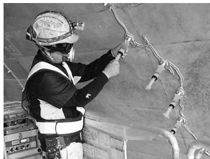
写真-1 補修材の注入状況
