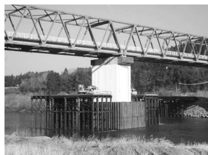
写真-4 仮橋設置状況
