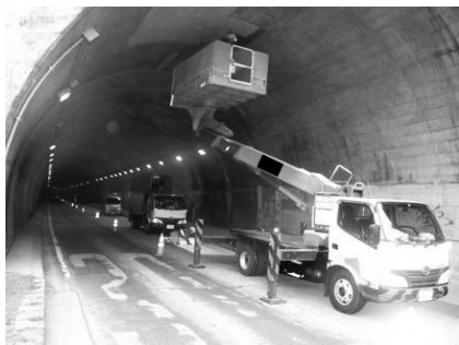
写真-2 補修材の注入状況（全景）
