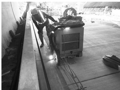
写真－7 目地切りの施工状況
