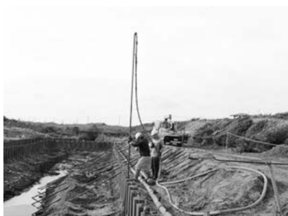
写真-3 ウェルポイント設置状況
