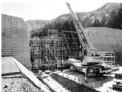
写真－6 鋼製砂防（鋼管フレーム型）の据付状況
