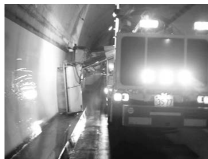
写真－8 トンネル清掃車による壁面清掃状況
