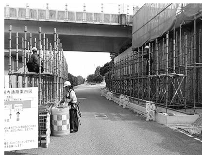
写真-14 支柱支保設置状況
