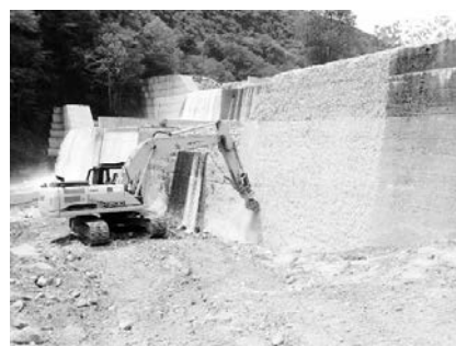
写真-5 砂防堰堤のチップング状況
