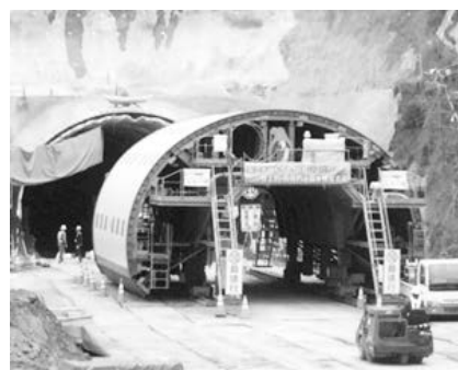
写真-11 スライドセントルの組立状況
