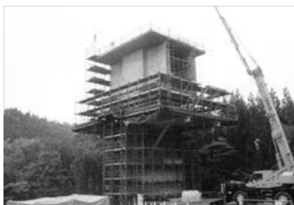
写真-13 柱頭部施工状況
