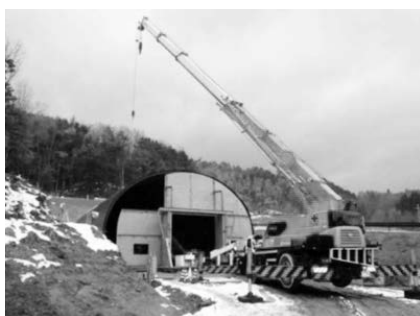
写真-12 防音扉の設置状況
