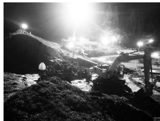
写真-6 破堤箇所の仮復旧工事
