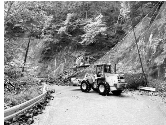
写真-3 土砂撤去工事
