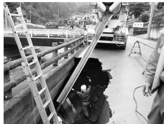
写真-5 道路陥没箇所の復旧
