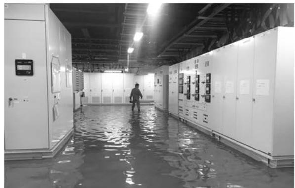
写真－2 地下電源設備の浸水被害
