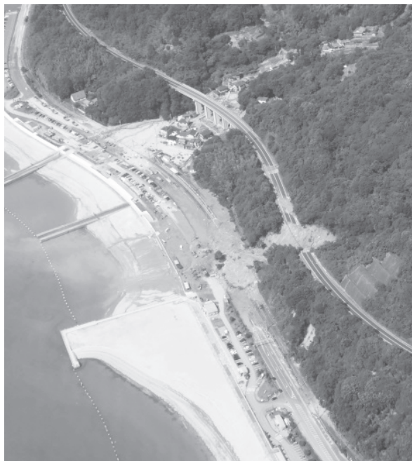
写真-2 沿岸に集中する交通手段への土砂崩壊 (広島県安芸郡坂町：平成30年7月)
