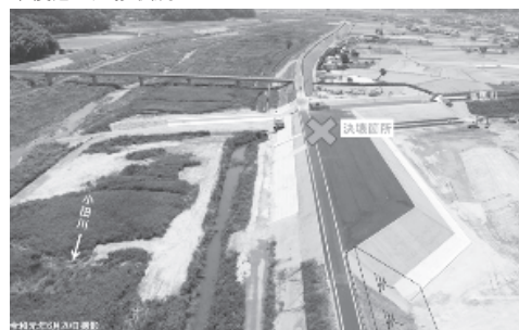
写真-5 本復旧状況（小田川決壊箇所）
