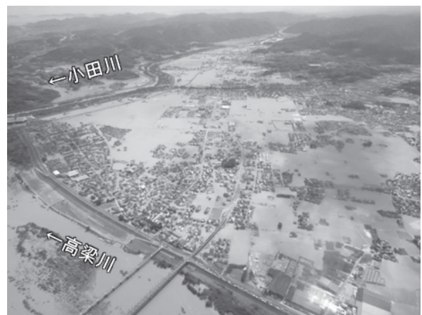
写真－1 倉敷市真備町の被災状況
