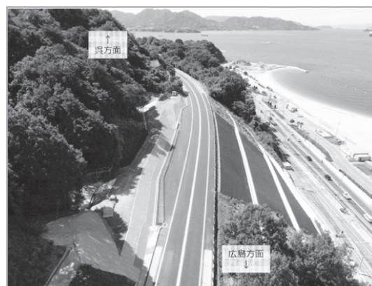
写真-6 広島県道路復旧完了（H30.9.27）
