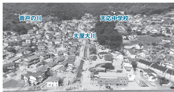
写真-3 【土砂・洪水氾濫】大屋大川(呉市天応)
