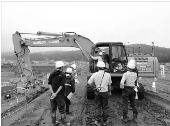
写真－12 ICT 施工現場の見学会
