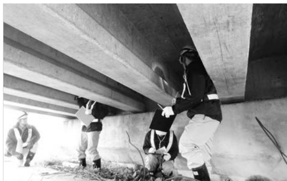
写真-4 高校生と協働による橋梁点検の状況
