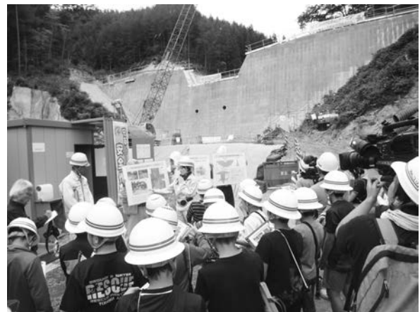
写真-5 小学生による砂防工事現場の見学
