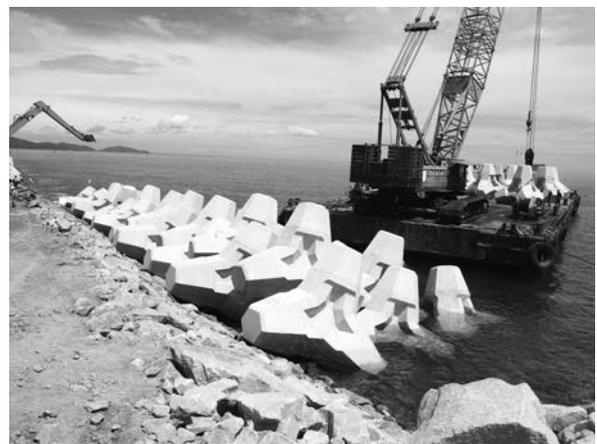
写真-3 ベトナム チャンマイ港 防波堤 (施工中)
