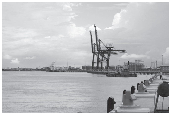
写真-2 供用したプロット25及び26の岸壁(クレーン周辺)
