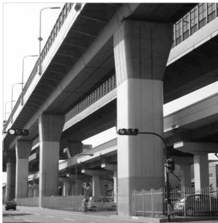
阪神高速道路の橋脚
