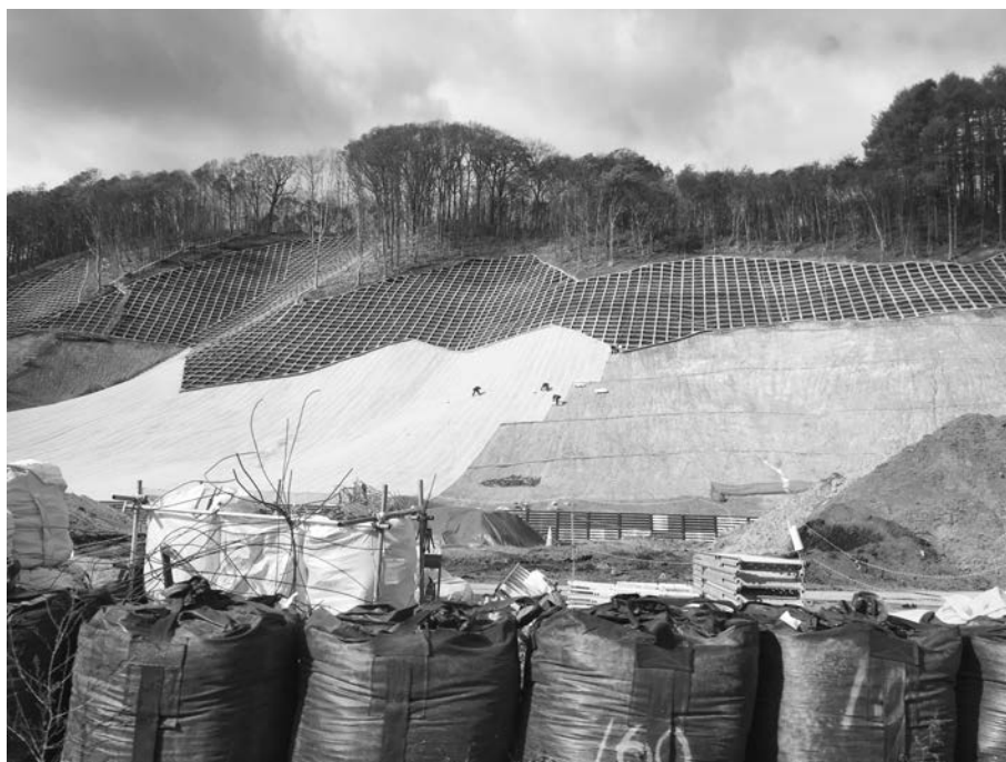
写真－3 2019年11月 北海道胆振東部地震 厚真町の復旧工事（新保撮影）
