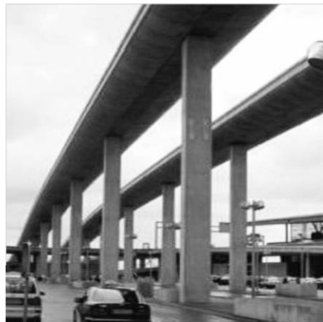
フランス シャルル・ド・ゴール空港 アクセス道路の橋脚
