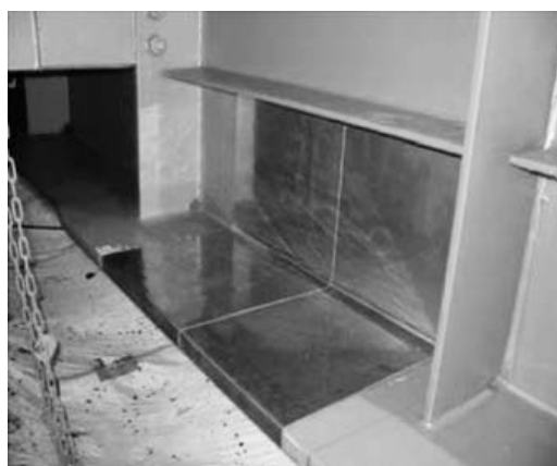
写真－3 チタン箔シート貼り付け状況
