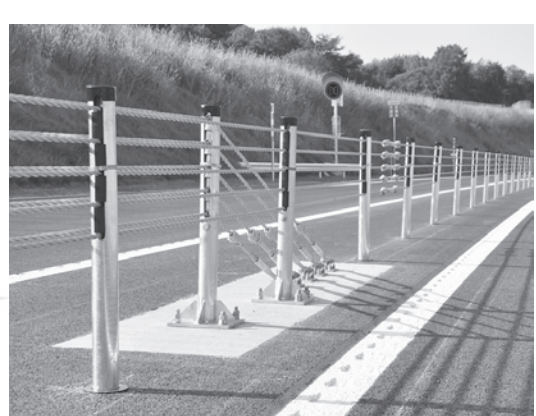
写真－2 ワイヤロープ式防護柵の設置状況
