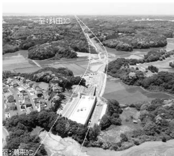
写真－7 川尾地区（本線函渠工事）
