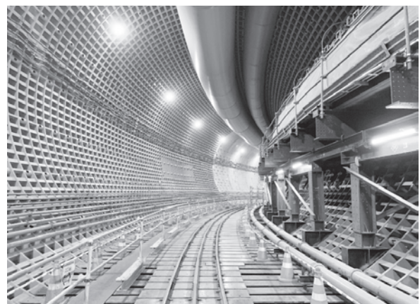
写真－6 横浜湘南道路（トンネル内部）
