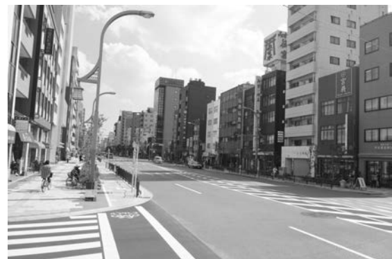
写真-1 遮熱性舗装の外観写真（浅草通り）
