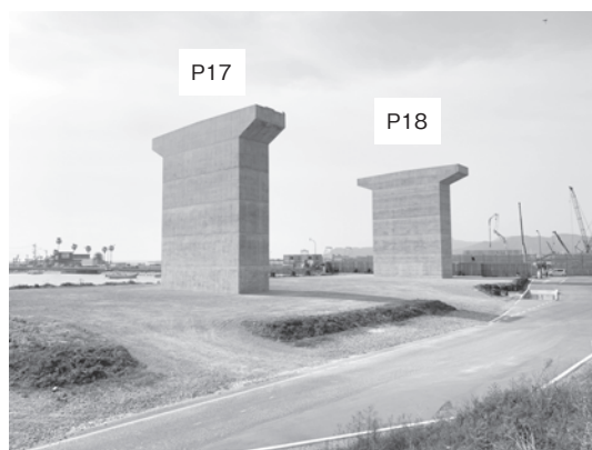
写真-1 工事完成写真
