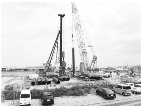
写真－3 鋼管杭施工状況
