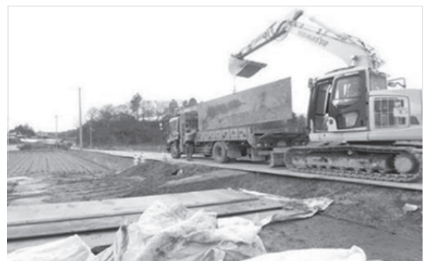
写真－16 敷鉄板撤去状況
