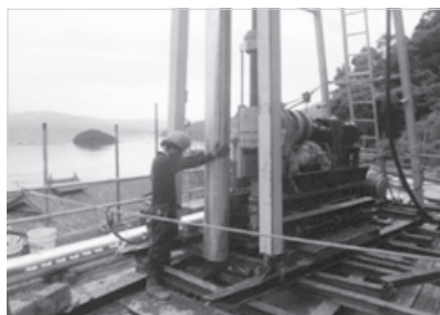
写真－13 大口径ボーリングマシ ン工法（B工法）
