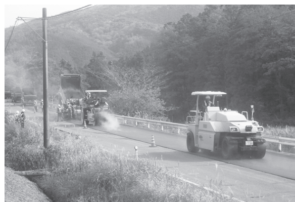
写真-20 締固め作業状況
