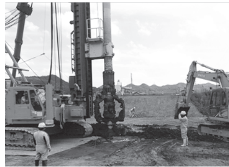
写真－２ 貫入攪拌状況
