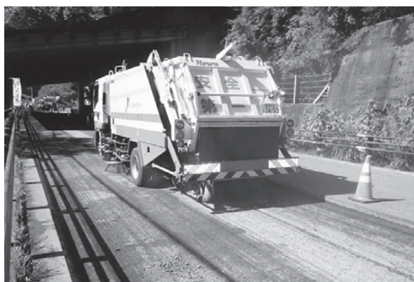
写真-18 切削廃材の清掃作業状況
