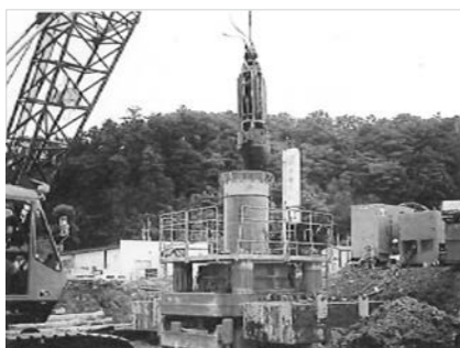
写真－8 掘削状況
