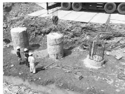
写真－10 杭頭処理
