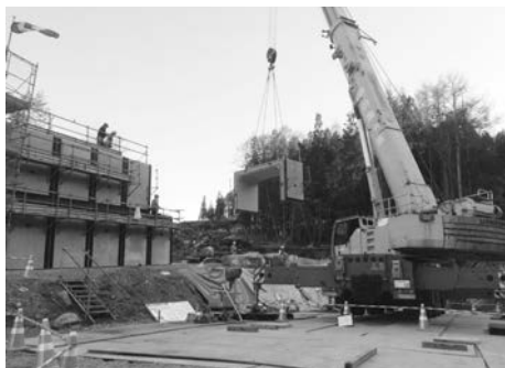
写真-4 大型ボックスカルバート組立状況
