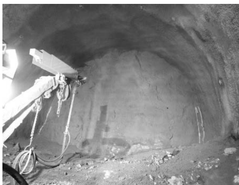
写真－21 鏡吹付施工状況
