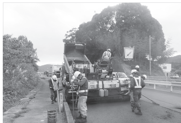
写真-19 舗設作業状況
