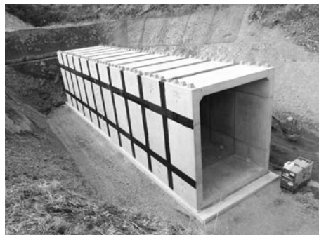
写真-7 施工完了
