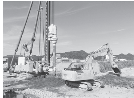
写真－３ 排出土処理状況
