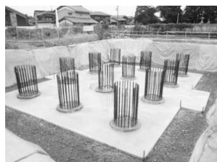
写真－11 施工完了
