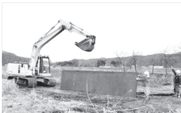
写真－15 敷鉄板設置状況
