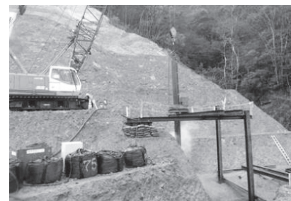
写真－14 テーブルマシン工法 （C工法）
