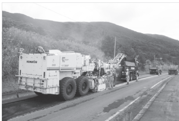
写真-17 舗装路面の切削作業状況
