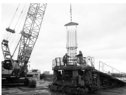
写真－9 鉄筋かご建込状況
