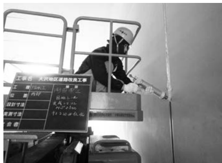
写真-6 目地作業状況
