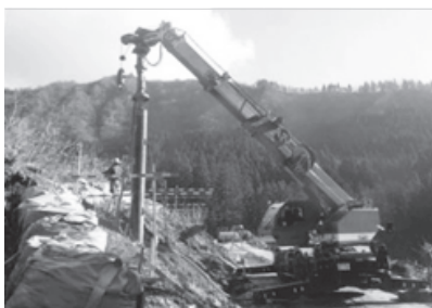
写真－12 ラフテレーンクレーン 工法（A工法）
