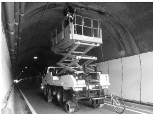
写真-3 電磁波探査による調査状況
