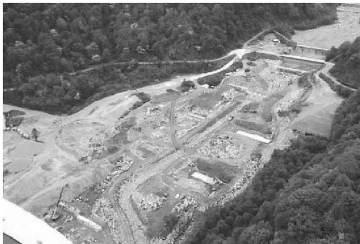
写真 4 施工箇所全景
