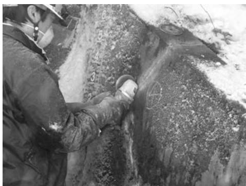
写真-1 ひび割れ面のカット
