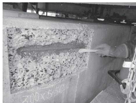
写真-10 鉄筋防錆処理
