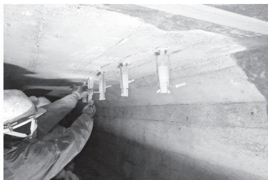
写真-7 補修材の注入状況①
