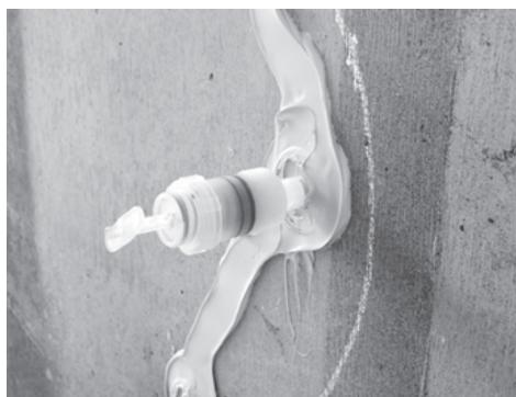
写真-8 補修材の注入状況②
