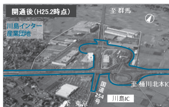
写真－4 圏央道川島IC（開通後）
