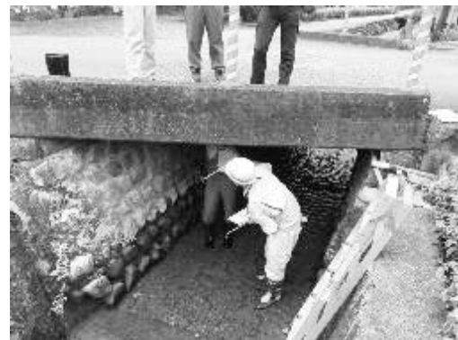
写真-2 高校生による床版橋の打音確認
