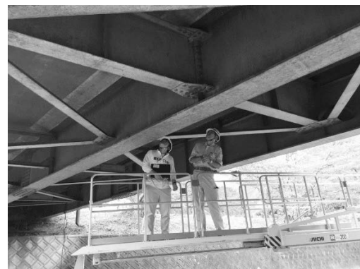
写真-1 橋梁点検車を使った橋梁点検の体験
