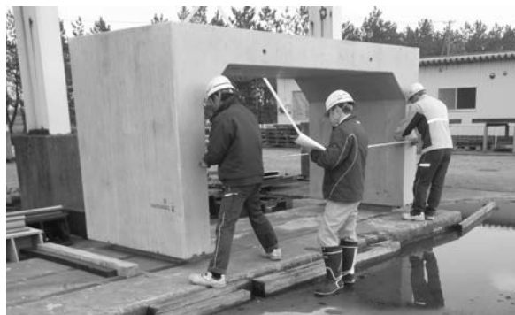
写真-1 立ち入り検査状況
