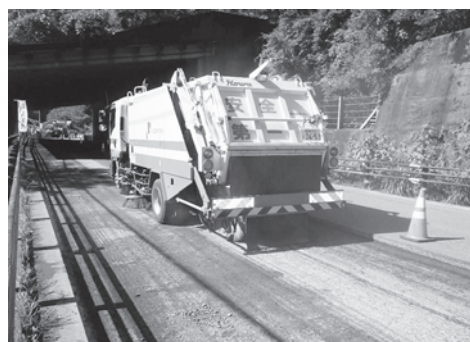
写真-13 切削廃材の清掃作業状況
