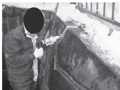
写真-3 補修材の充てん状況
