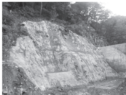
写真-2 施工後全景
