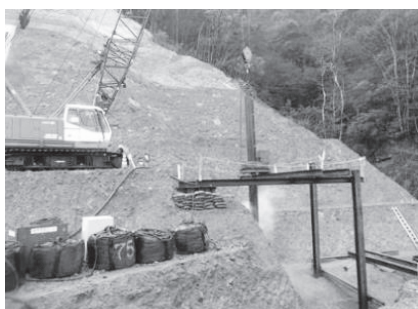
写真-10 テーブルマシン工法の削孔状況
