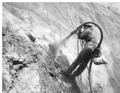
写真－1 仮設用モルタル吹付状況
