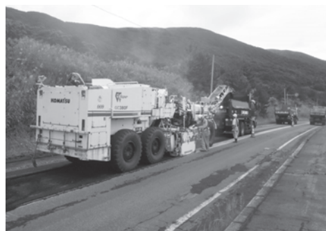
写真-12 舗装路面の切削作業状況
