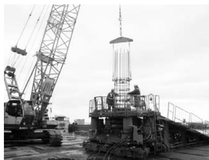
写真-9 鉄筋かご建込状況
