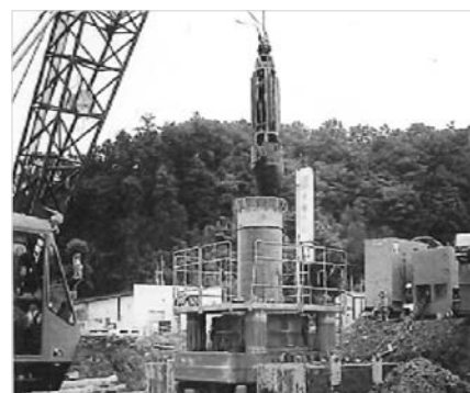
写真-8 掘削状況
