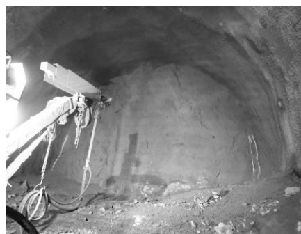
写真－14 鏡吹付施工状況
