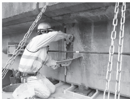
写真-5 断面修復状況
