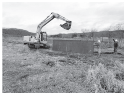
写真-11 敷鉄板設置状況
