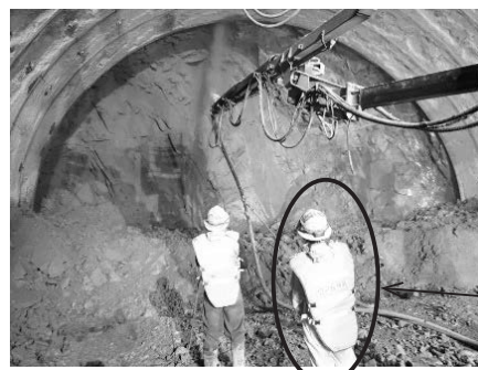
写真－15 切羽監視責任者の配置状況
