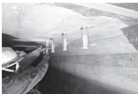
写真-4 補修材の注入状況
