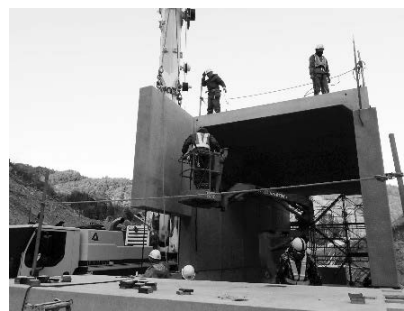
写真-7 大型ボックスカルバート接続状況
