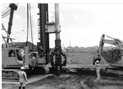
写真-6 貫入攪拌状況
