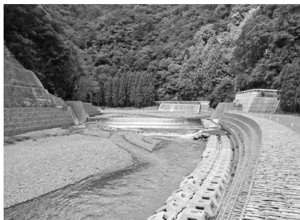
①田辺市本宮町三越地区：砂防堰堤，護岸の整備
