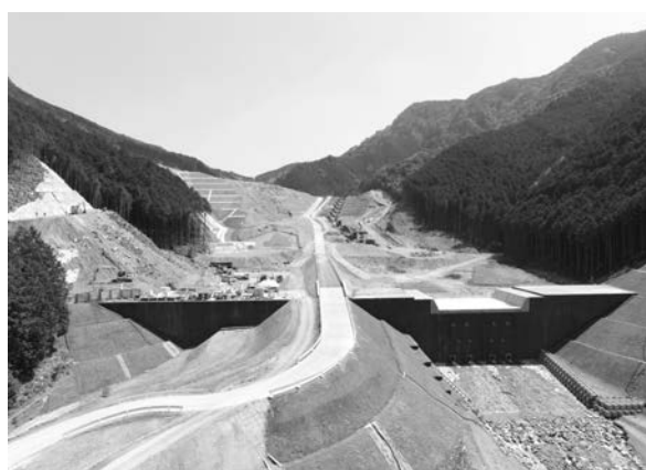
②田辺市熊野地区：砂防堰堤の整備
