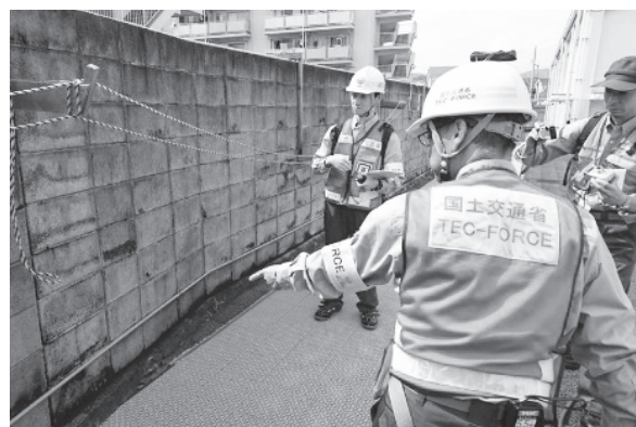
写真-4 ブロック塀の応急危険度判定 (大阪府高槻市)
