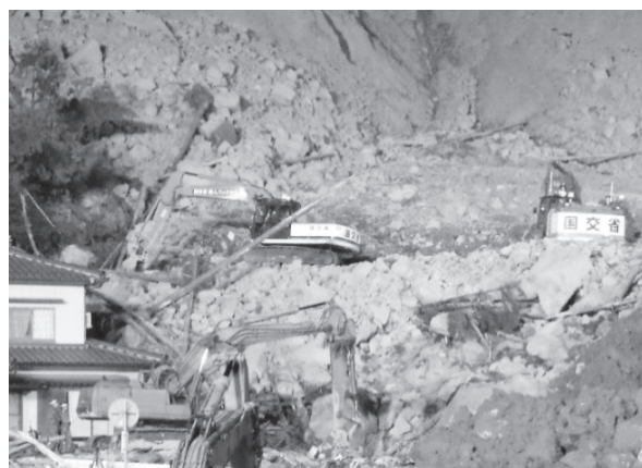
写真-3 遠隔操作式バックホウによる捜索支援活動状況 (大分県中津市)
