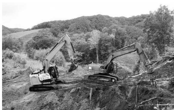
写真－15 自衛隊と連携した道路啓開（北海道厚真町）
