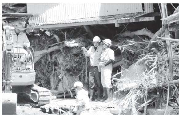
写真－8 まちなかに堆積したのがれき等撤去の技術的支援（広島県呉市）
