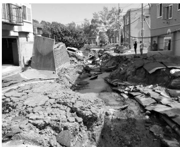
写真－13 液状化状況（北海道札幌市）
