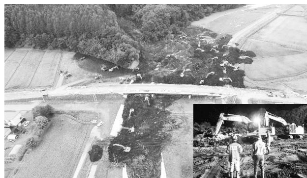
写真-9 河道閉塞土砂撤去状況（厚真町 厚真川）
