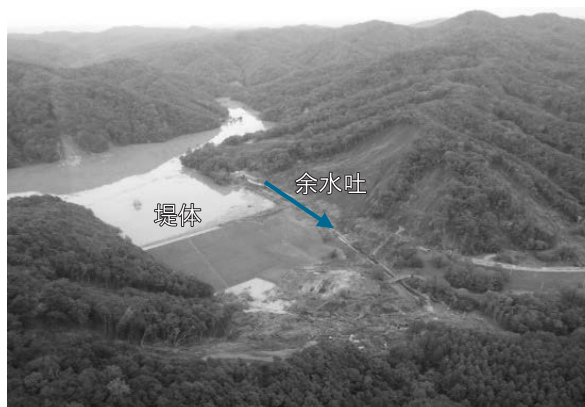
写真－6 余水吐の閉塞状況 (厚真ダム)
