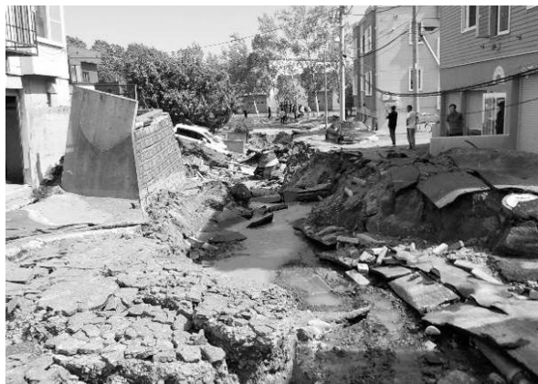
写真－2 住宅街での道路の著しい変状 (札幌市 清田区)
