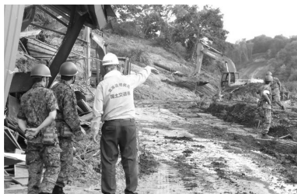
写真-8 道路啓開状況（厚真町 町道幌内線）
