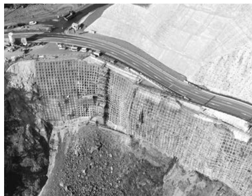
写真－6 道路下斜面施工状況
