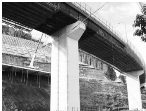
写真－3 大切畑大橋施工状況
