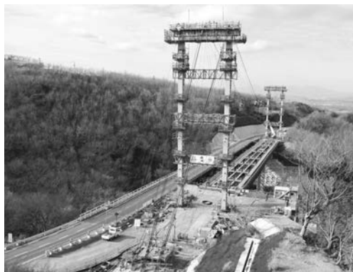
写真－4 俵山大橋施工状況
