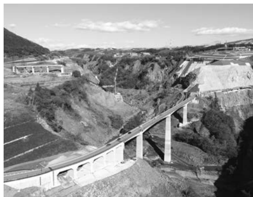
写真－5 村道栃の木～立野線全景
