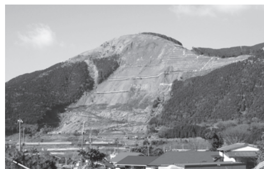
写真－1 阿蘇大橋地区全景
