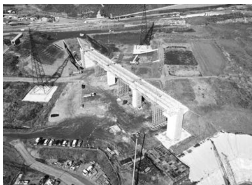
写真－2 阿蘇大橋アプローチ部施工状況
