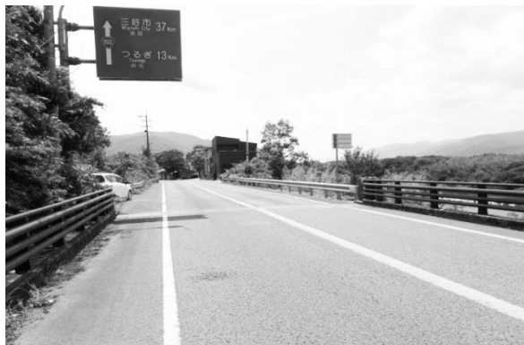
写真－1 第1ブロック
