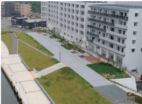
写真-6 中央1丁目地区完成
