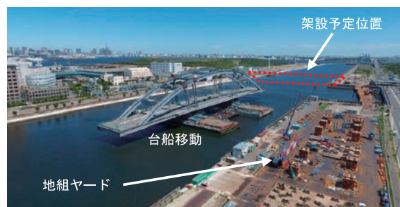
写真－3（仮称）東西水路横断橋架設状況（平成30年8月）
