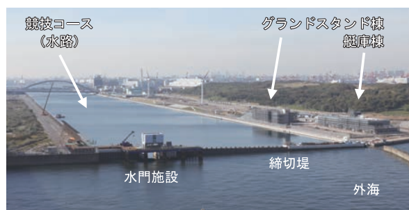
写真－2 海の森水上競技場（平成30年11月）
