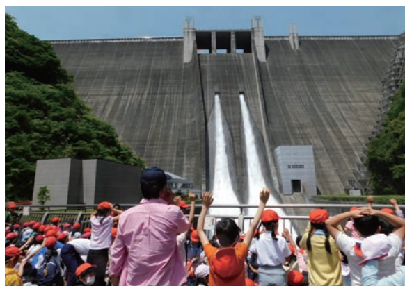
写真－1 宮ヶ瀬ダム（神奈川県）
