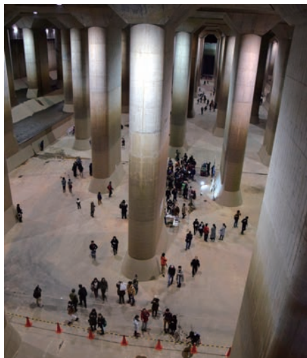
写真－3 首都圏外郭放水路（埼玉県）
