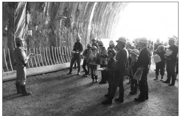
写真-1 親子でトンネル工事見学
