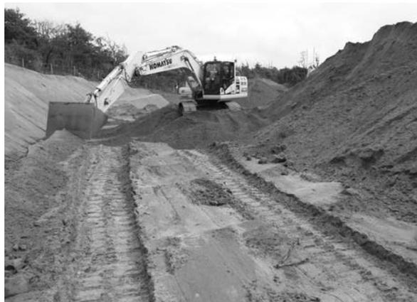
写真-2 3DMCバックホウによる施工状況
