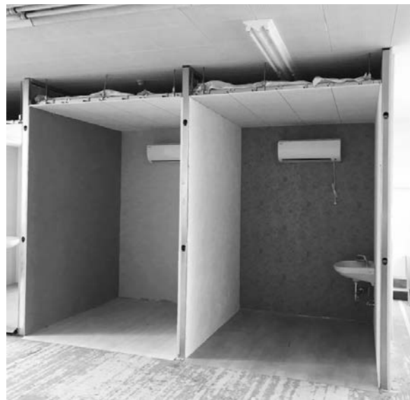
写真-3 完成したモックアップ
