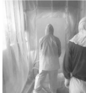
⑥耐火被覆実習
