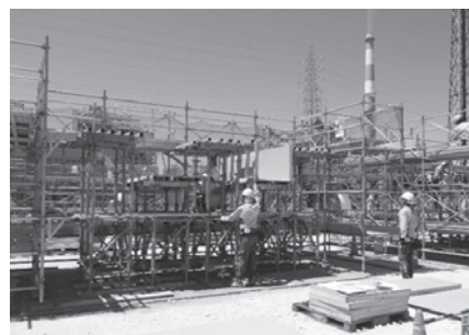
写真－４ 型枠組立
