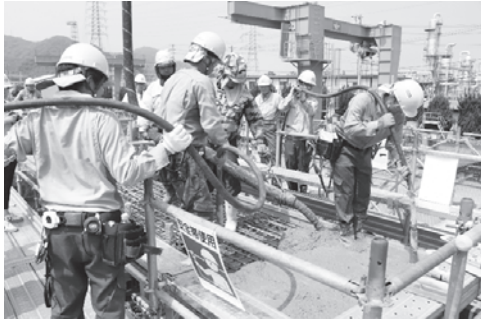
写真-7 コンクリート打設
