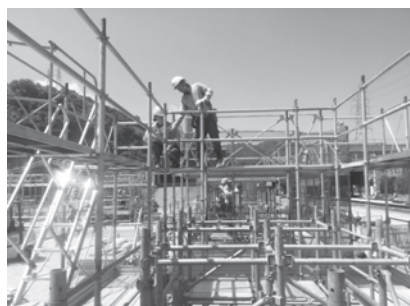
写真－３ 足場組立
