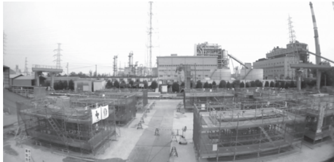
写真-9 足場組立完了全景
