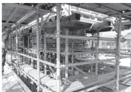
写真－５ 型枠支保工組立
