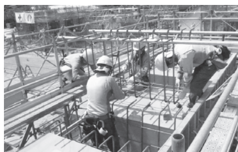
写真－６ 鉄筋組立
