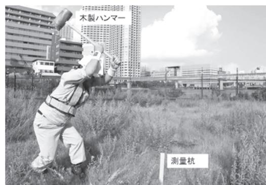
写真-1 杭打ち作業の例
