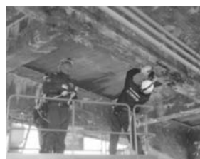
写真－1 橋梁の直轄診断の様子
