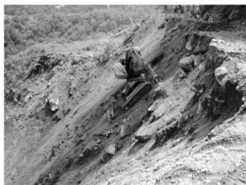
写真－3 ロッククライミングマシンの無人化施工
