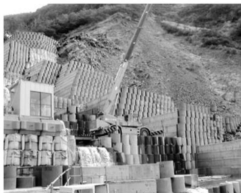
写真－2 遠隔操作クレーンによる無人化施工
