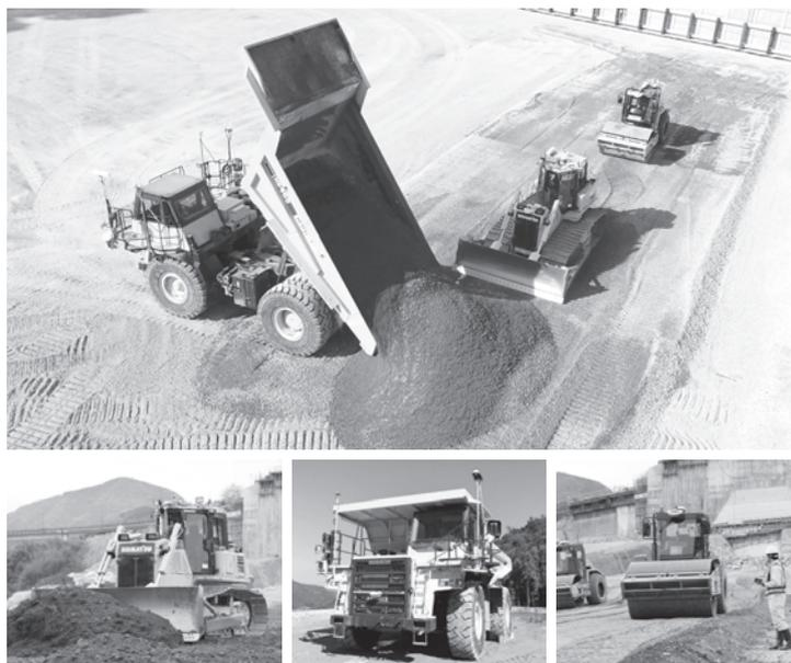
写真-1 自律型無人化施工システム（鹿島建設提供）
