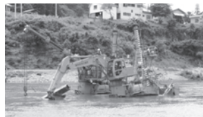
重機による水中作業
