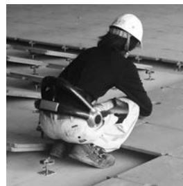
写真-3 OAフロアでのしゃがみ込み作業
