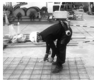
写真-5 床鉄筋結束
