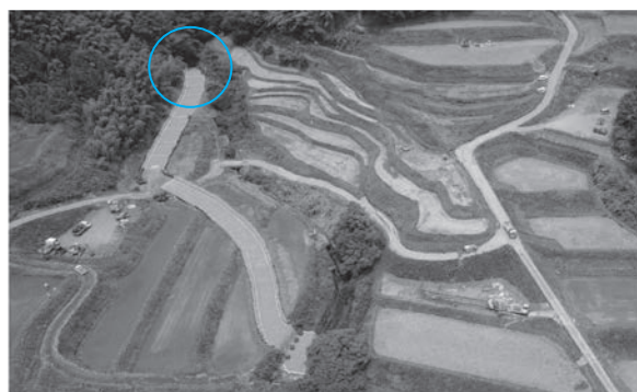
写真－9 平井川仮排水路（○の範囲が、遠隔操縦）
