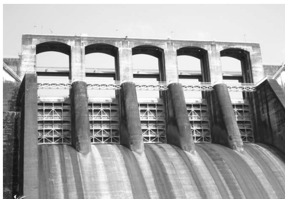
写真-1 丸山ダムの放流設備
