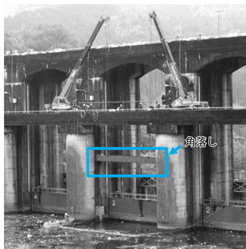
写真-2 角落し設置状況 (クレーン 2 台による相吊り)
