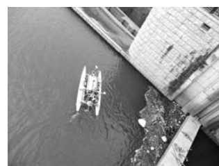
写真－7 水中点検ロボット調査状況
