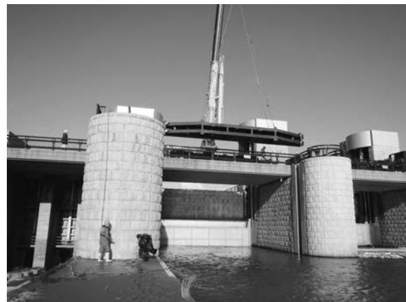
写真－5 予備ゲートの設置状況
