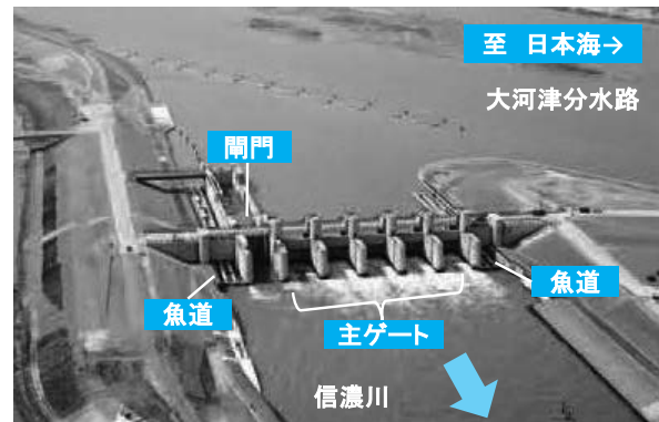
写真－4 大河津洗堰 全景（下流側より撮影）
