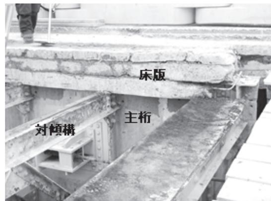
写真-4 主桁上フランジが床版の中に埋まっている
