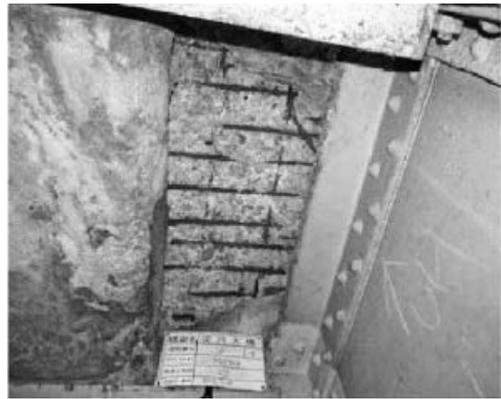
写真-1 コンクリートの「剥離」鉄筋露出
