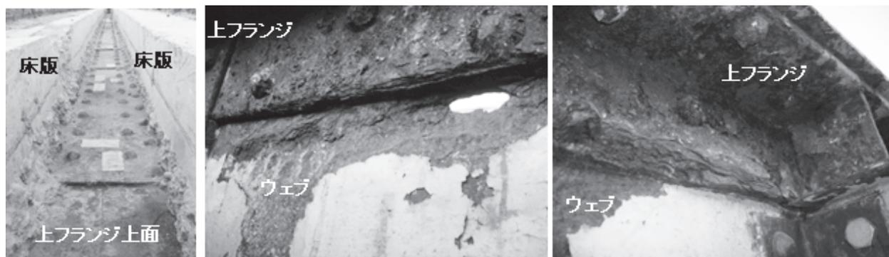
写真－5 床版に埋もれている主桁上フランジ及びウェブ上部の状況
