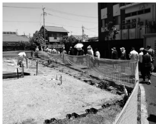
写真－3 液状化対策の実証実験・現地見学会（熊本市）
