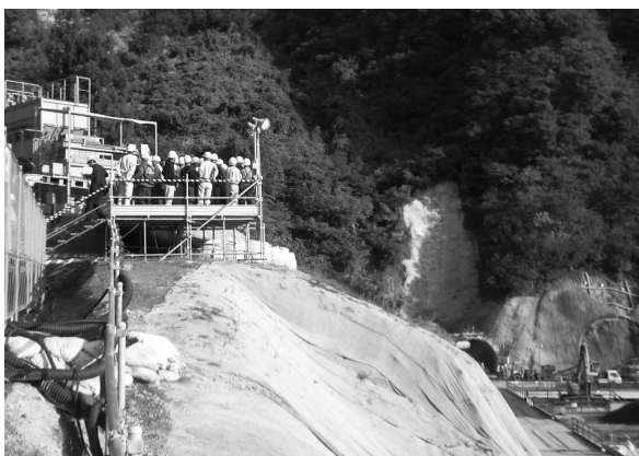
写真—4 高台よりトンネル建設現場を視察
