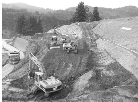
写真—7 大規模土工の施工状況
