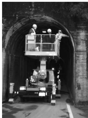
写真－1 トンネル点検状況
