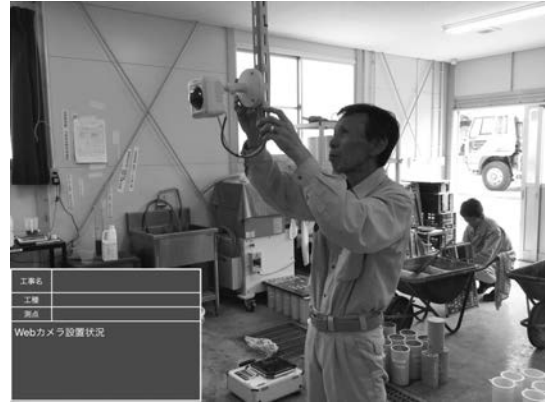
写真-1 Webカメラ設置状況
