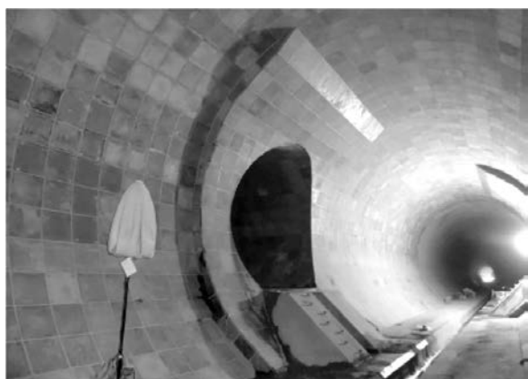
写真－1 構造部材型埋設型枠（トンネル覆工）の適用事例
