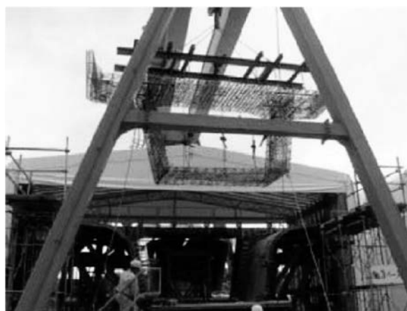
写真－2 プレハブ鉄筋のプレキャストセグメントへの適用事例
