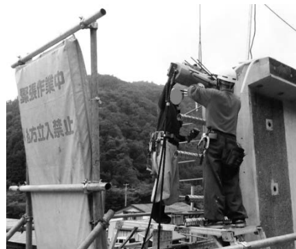
写真-3 PCケーブル緊張状況
