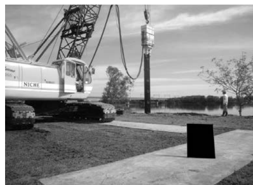
写真-6 打込み状況
