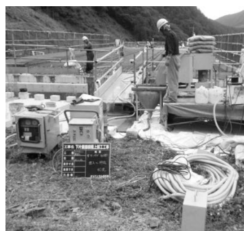
写真-4 グラウト注入状況
