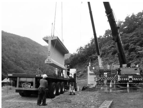
写真-1 セグメント取卸状況
