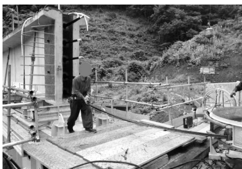
写真-2 PCケーブル挿入状況
