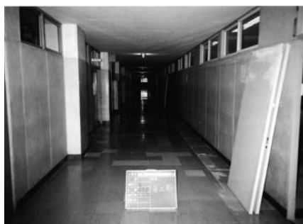
写真－7 改修前の廊下
