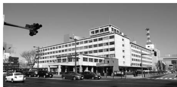
写真-3 改修前の県庁舎（平成26年3月）
