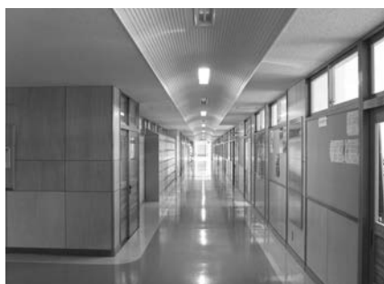
写真－8 改修後の廊下
