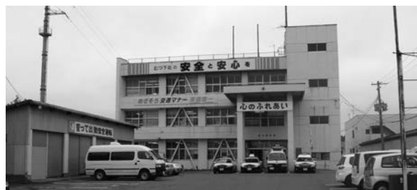
写真-1 改修前（むつ警察署）
