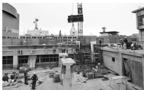
写真-5 減築工事の状況（平成28年6月）
