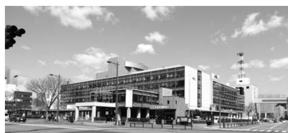
写真-4 施工状況（平成30年4月）
